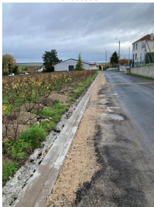
Après pose des caniveaux, avant réfection chaussée
