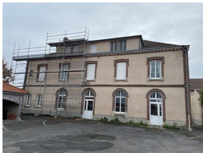
Echafaudage derrière la mairie
