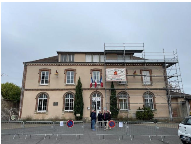
Echafaudage en façade de la mairie
