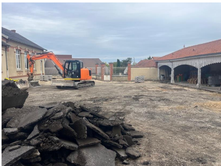
Pendant les travaux
